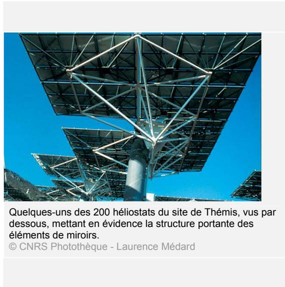
Quelques-uns des 200 héliostats du site de Thémis, vus par dessous, mettant en évidence la structure portante des éléments de miroirs.
