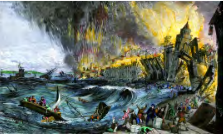
Gravure du XIX e siècle représentant les terribles séisme et raz-de-marée qui ont causé la destruction de nombreux édifices à Lisbonne en 1755.
