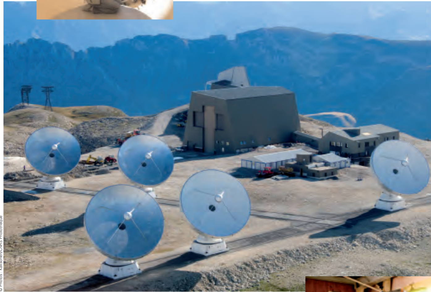
L'interféromètre de Bure est constitué de six antennes de 15 mètres de diamètre chacune.
