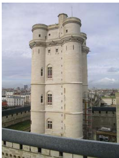
Photo 1 - Le donjon après restauration.
