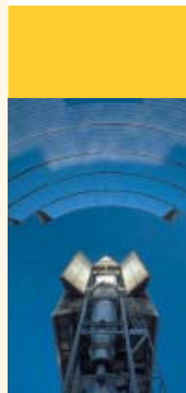
Le CNRS participe à la construction et à l'exploitation de grands équipements, au bénéfice de toute la communauté scientifique. Ici, le four solaire d'Odeillo, qui concentre le rayonnement solaire.
